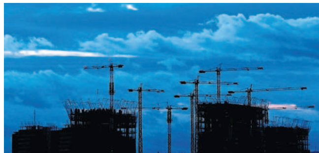
Promoción de vivienda nueva en construcción en Valencia. EFE
