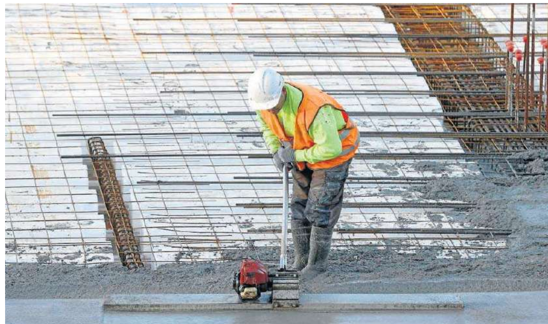
Un albañil efectúa un trabajo en una vivienda en construcción.
