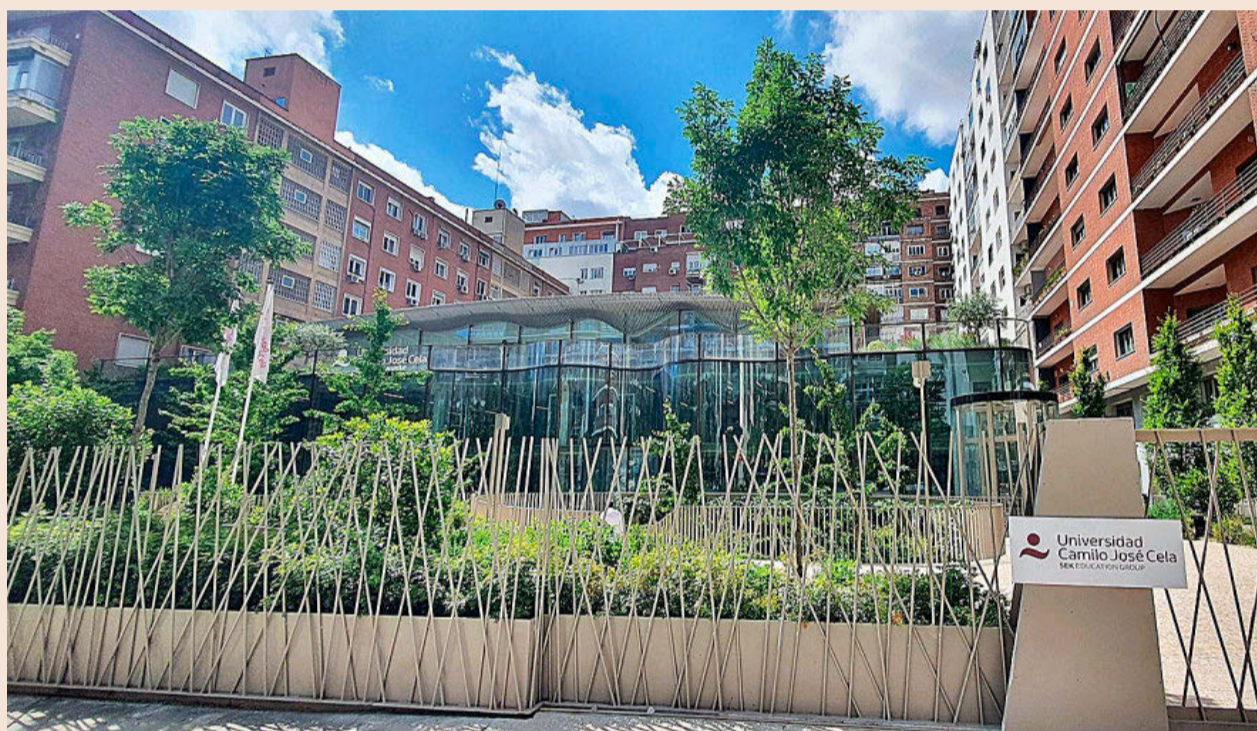
El edificio está ubicado en el número 4 de la calle Juan Hurtado de Mendoza, entre Cuzco y plaza de Castilla.
